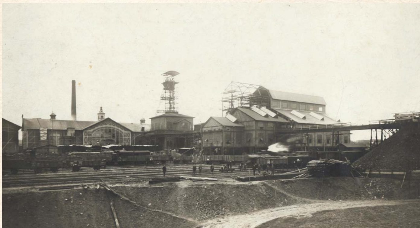
Fotografie z roku 1912 zachycující výstavbu budovy prádla. Soukromá sbírka.
