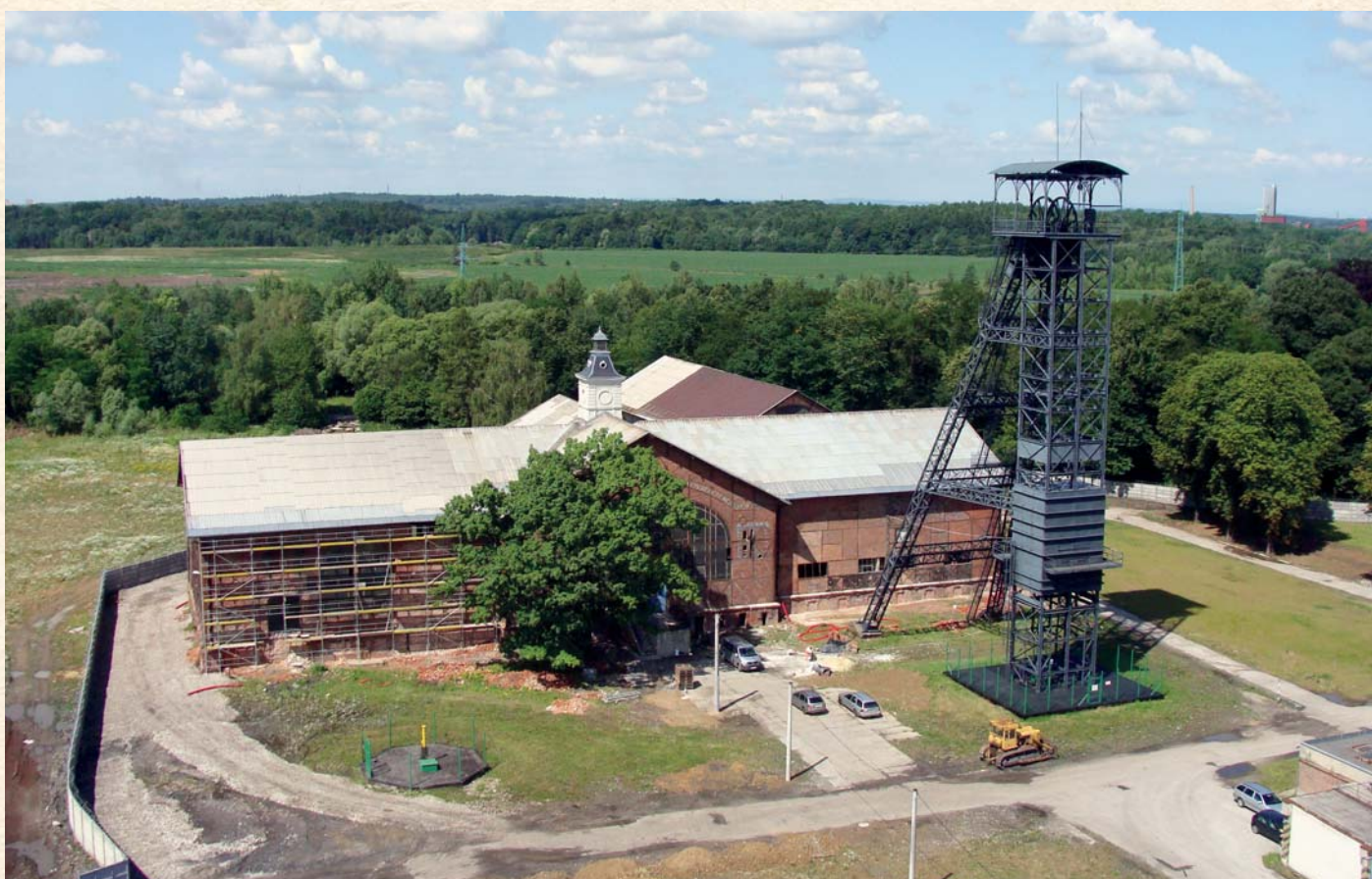
Letecký snímek zachycující opravu strojovny v roce 2014. Archiv DIAMO, s. p.
