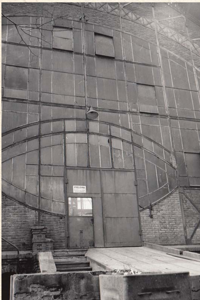
Detail eliptického vstupu do strojovny, 70. léta 20. století. Státní okresní archiv Karviná.
