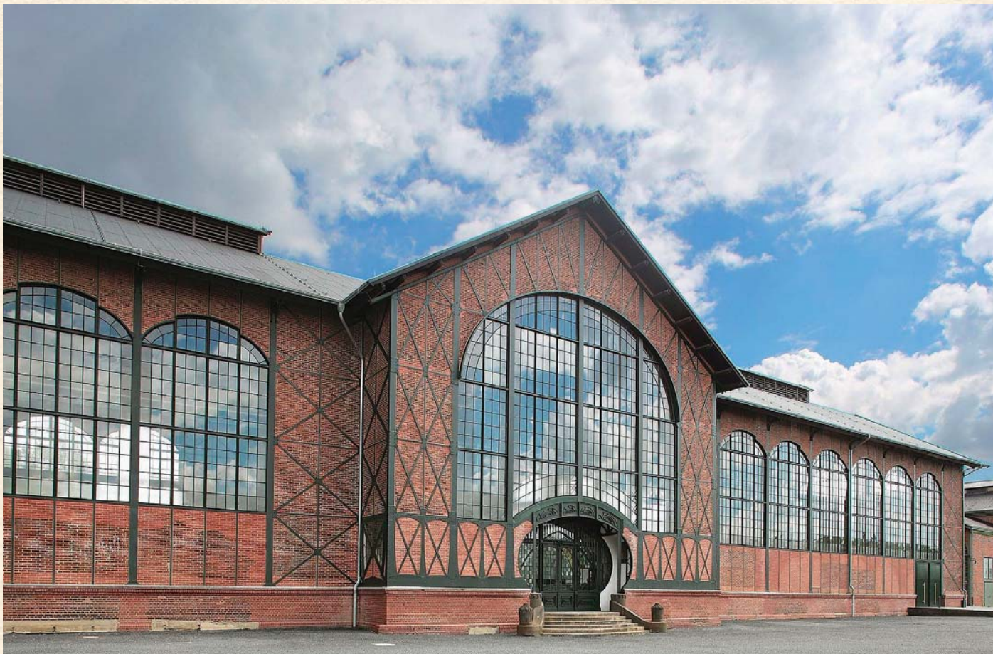
Budova strojovny Dolu Zollern II/IV v německém Dortmundu. Strojovna sloužila jako vzor pro stavbu strojovny Dolu Austria (Barbora).
